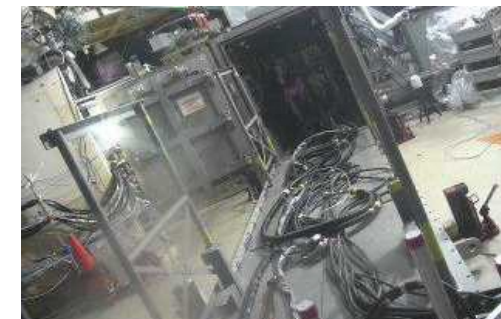
＜作業エリア＞ (遠隔操作での装置搬送後)
