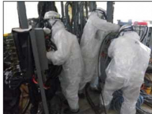
<モックアップ状況（ケーブル結線・解線）>
