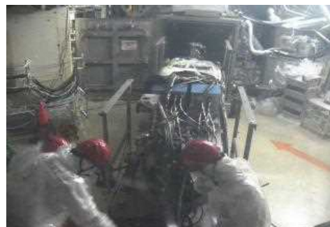
＜作業エリア＞ (遠隔操作での装置搬送前)
