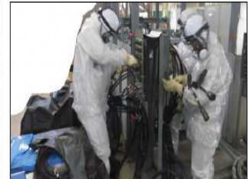
<モックアップ状況（ケーブル結線・解線）>
