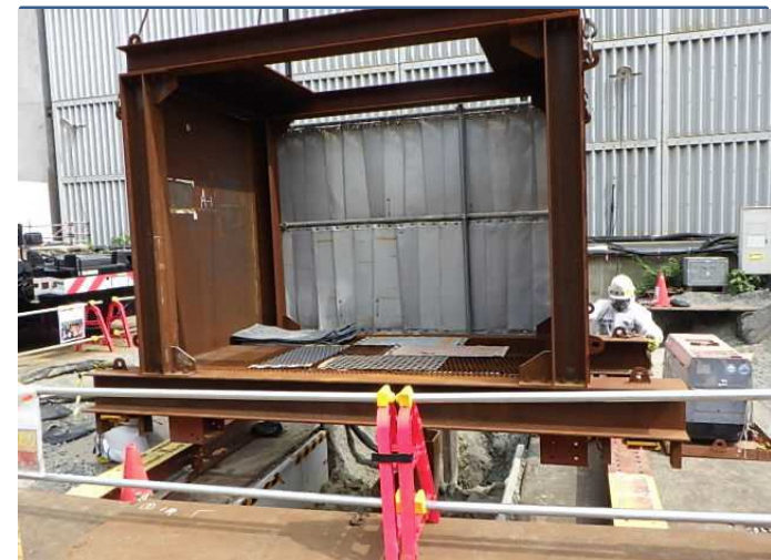
<遮蔽架台設置作業中の様子 (場所)>
