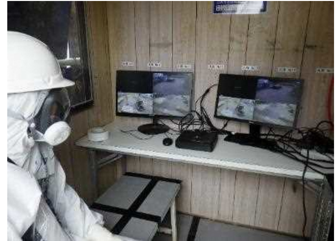
<遮蔽ハウス内の遠隔監視設備>
