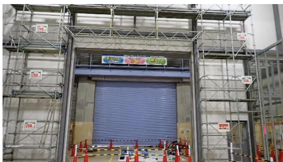
(写真 3-1) 定検資材倉庫Bの状況① (足場の組立の様子)
