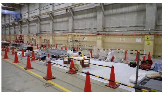
(写真 3-2) 定検資材倉庫Bの状況② (トラバーサ等の設置に向け、資機 材が運び込まれている様子)
