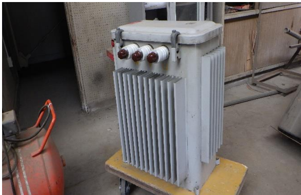
②変圧器(トランス)外観31-003
