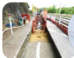
破損した 導水管を 複線化
