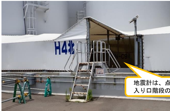
(写真2-1) H4北タンクエリアの外観 (東側から撮影)
