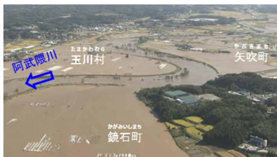
令和元年 10 月洪水状況写真 9)
