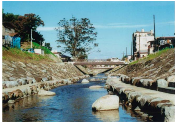
谷津田川（寒晒橋付近） 7) （多自然川づくりによる河川整備）
