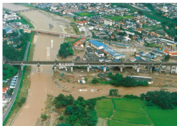
平成 10 年 8 月洪水状況写真 8)
