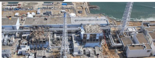
平成23年3月、東京電力(株)福島第1原子力発電所事故が発生
