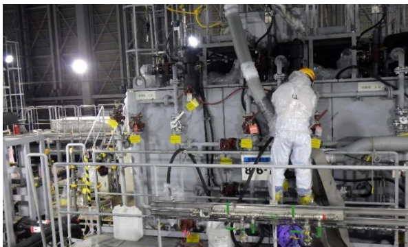
(写真 3 - 2) 吸着剤の搬送先である吸着塔 上部での作業状況② 搬入ラインのチェック状況
