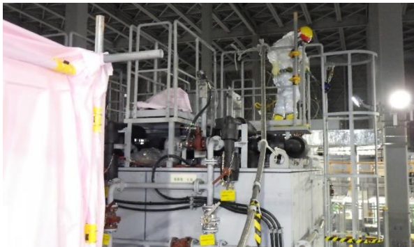
(写真 3 - 1) 吸着剤の搬送先である吸着塔 上部での作業状況① 搬入口での確認
