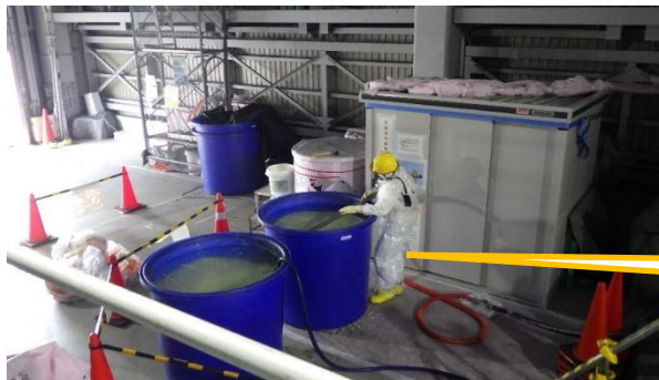
(写真1) 増設ALPS建屋内の状況 吸着材を吸着塔内に充填するための 吸着剤搬送作業
