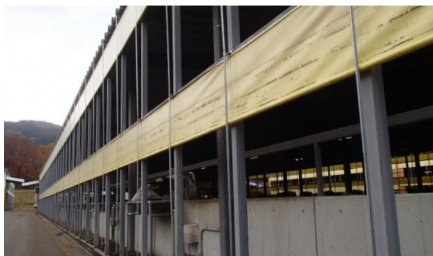
図5 牛舎内の換気のための巻き上げカーテン
