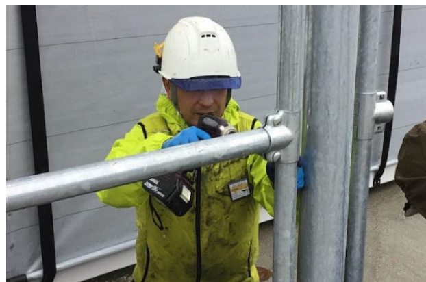
図6 施設内専用作業着で作業する作業員
