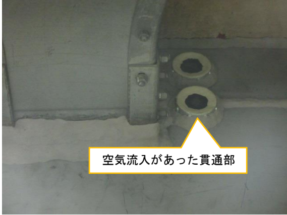
(写真 1—2) 貫通部の状況
