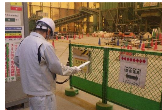
受入・分別施設の解体状況
