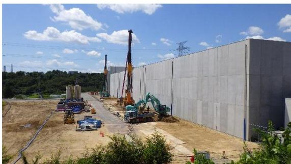
(写真1) 地盤改良工事
