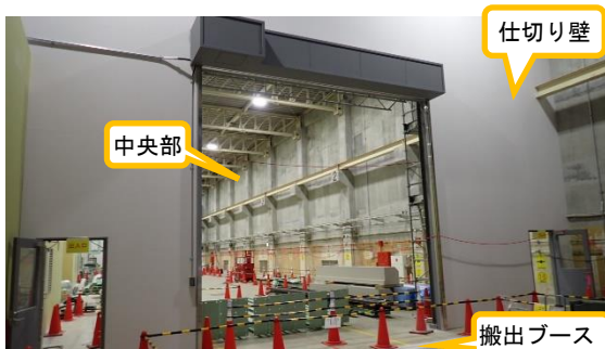
(写真1-2) 定検機材倉庫B東側の状況 (搬出ブース：仕切り壁設置済) (西側を向いて撮影)
