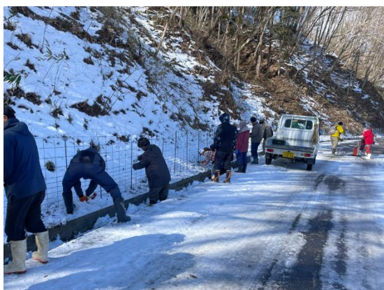
地域住民主体によるイノシシ侵入防止柵の設置作業
