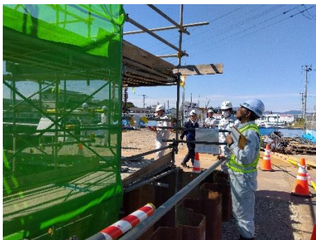
点検状況<郡山、田村方面>
