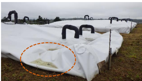
(写真2) 古い保管槽においては、 枝葉チップの腐食進行に 伴うと見られるシートの 窪みあり
