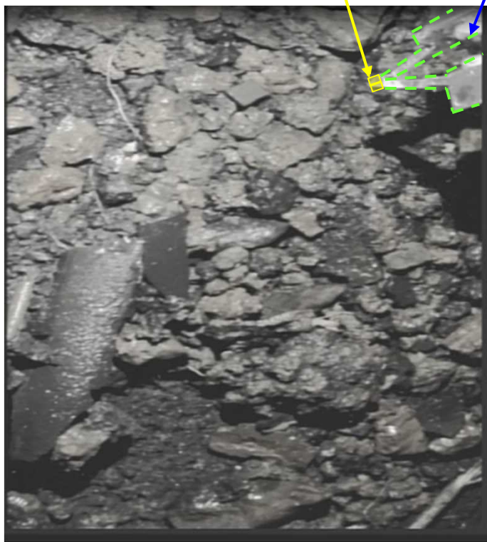
テレスコ式アームカメラの画像 (ペDESTAL底部の状況)
