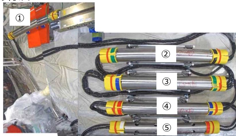
押し込みパイプの復旧作業の完了
