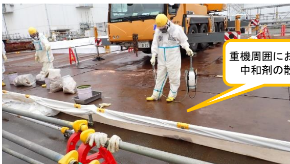
(写真1) 重機周囲の中和剤散布状況
