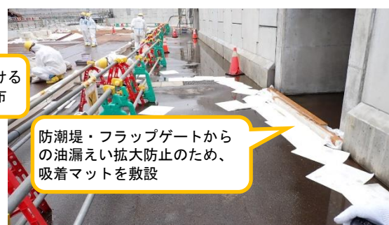
(写真2) 吸着マットの敷設状況
