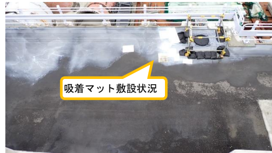
(写真3②) 乗入れ道路内の観測井戸1-5周辺における吸着マット敷設
