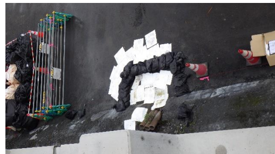
(写真4②) 同ゲートの油流出防止措置状況：漏えいがないことを確認
