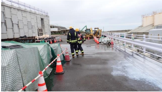
(写真3①) 防潮堤～2.5m盤乗入れ道路における中和剤散布と確認作業
