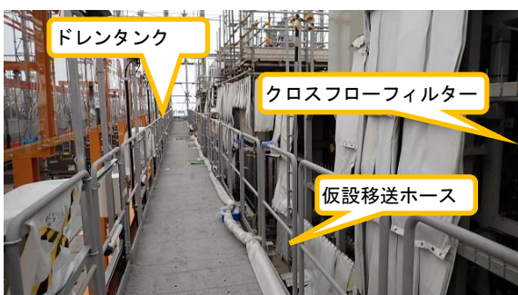
(写真2-1) 仮設移送ホースの敷設状況
