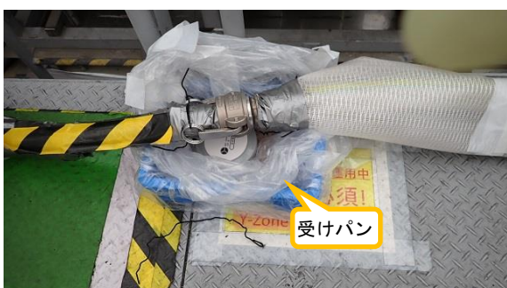
(写真2-2) 仮設移送ホース接続部の状況
