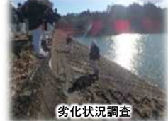
劣化状況調査
