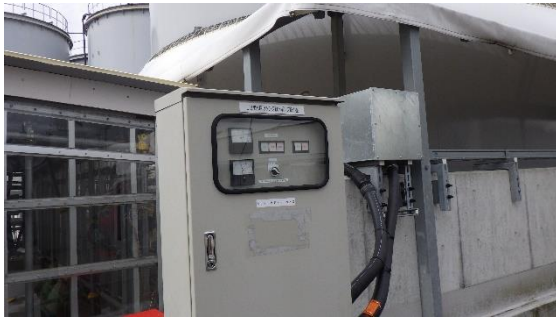
(写真 2 ①) J3タンク雨水回収タンク 散水ポンプ操作盤
