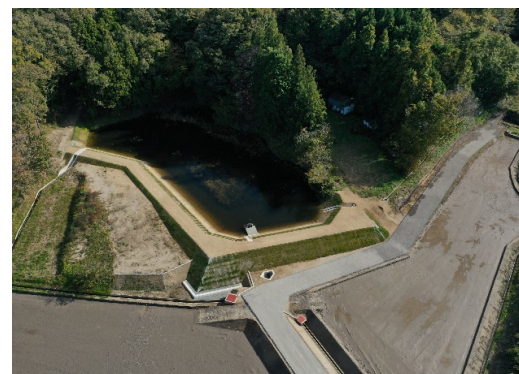
【施工後（永谷地区 0302 工事）】
