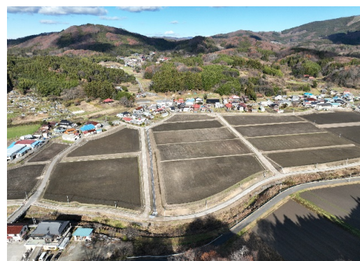
【施工後（北移地区 0301 工事）】
