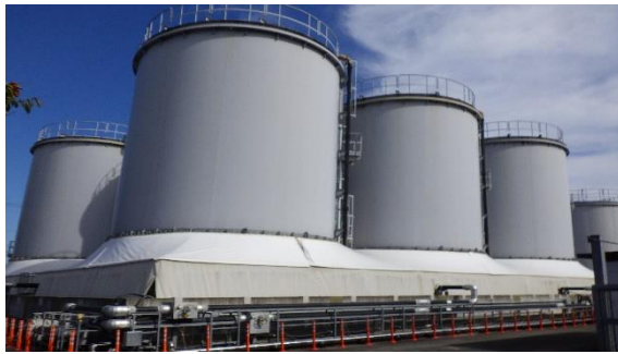
(写真3) J8タンクエリア外観 (南西側から撮影)
