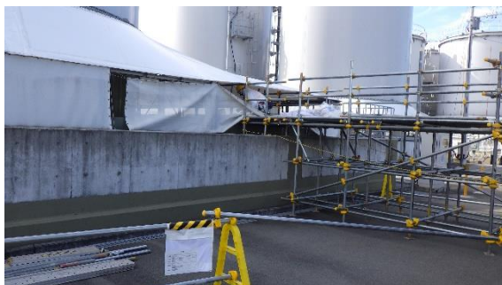
(写真1-2) J9タンク内残水移送ポンプ設置作業に使用する足場の設置状況 (北東側から撮影)
