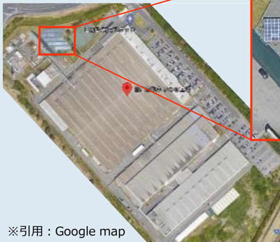
太陽光パネル設置状況
