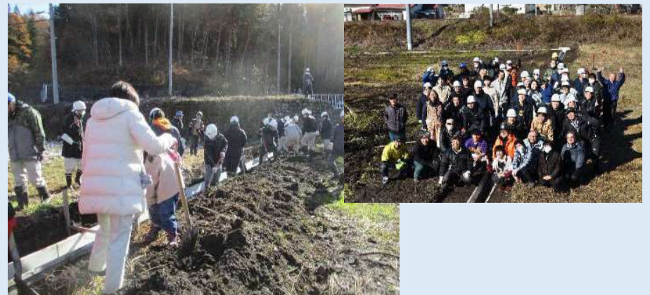
写-4 地域の方と協議会員による竹筋コンクリートU字溝設置
