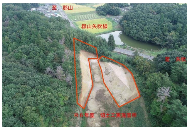
切土工事（上空から撮影）
