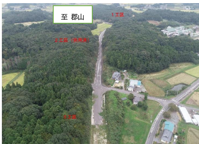
大久保工区工事状況
