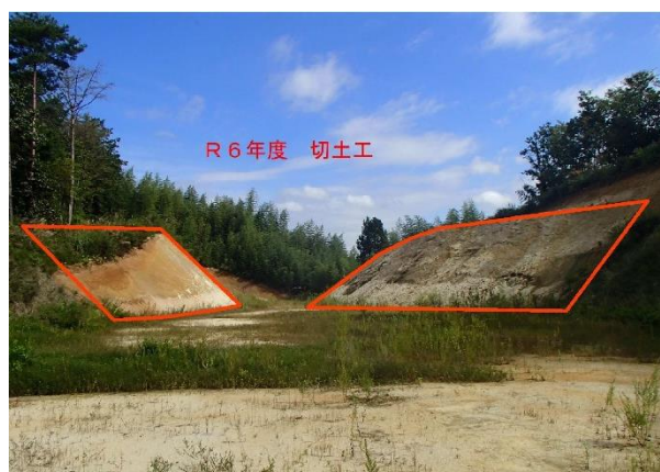
切土工事（矢吹側から撮影）
