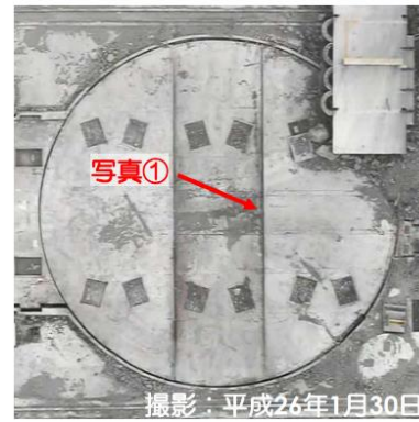
除染作業(小がれき集積)進捗後
