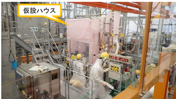
(写真1-1) 排水タンクからの残水移送作業の状況①
