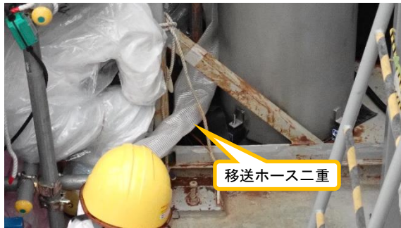
(写真 1-4) 排水タンクからの残水移送作業の状況④
