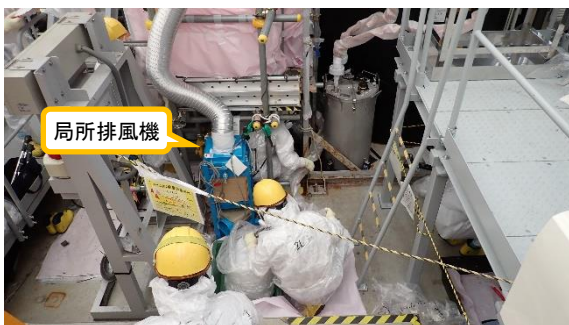
(写真1-2) 排水タンクからの残水移送作業の状況②
