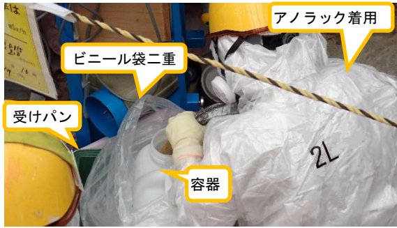
(写真 1-3) 排水タンクからの残水移送作業の状況③
