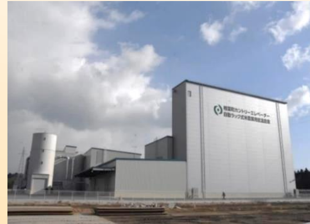
カントリーエレベーター・ 自動ラック式米農業用低温倉庫
