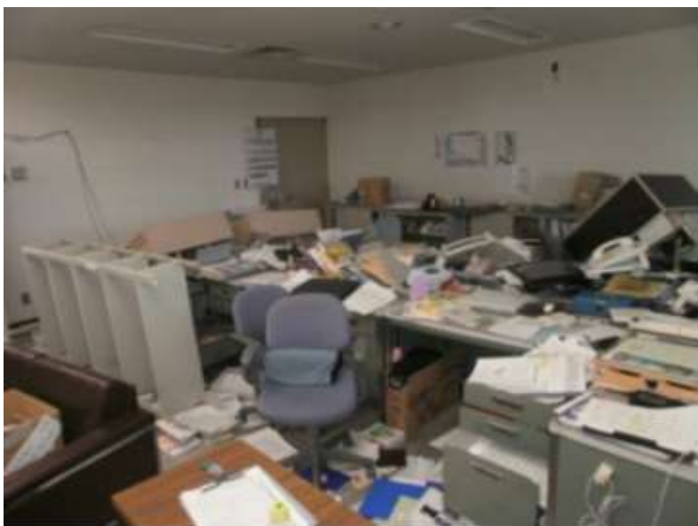
地震直後の役場庁舎3階事務室
