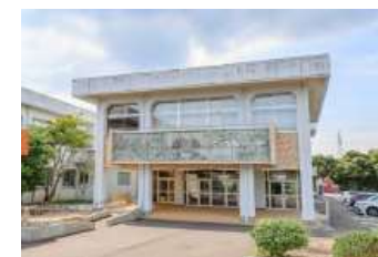
旧大野小学校 校舎を改修
