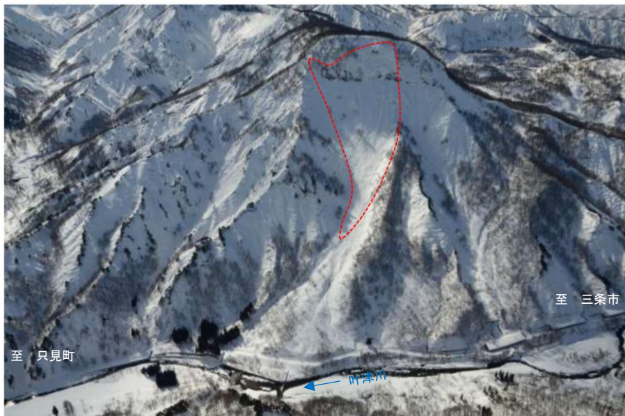
写真3 冬期現場状況
