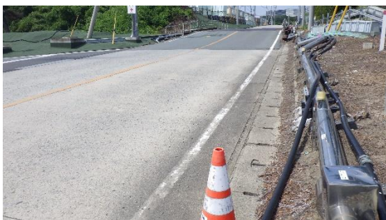
(写真5-2) 防火帯の状況② ※6号機北西の状況を東側から撮影
