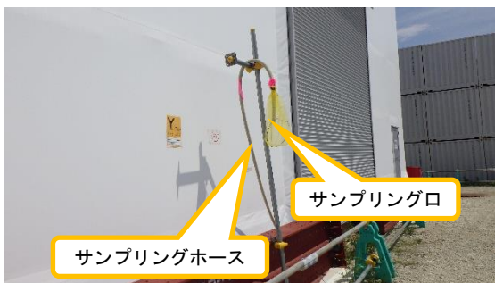
(写真2-2) 連続ダストモニタサンプリングロ の設置状況
