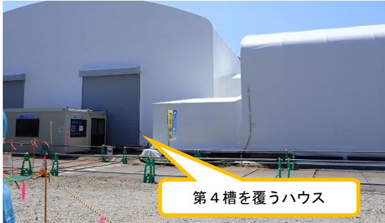
(写真1-1) 仮設ハウスの設置状況
