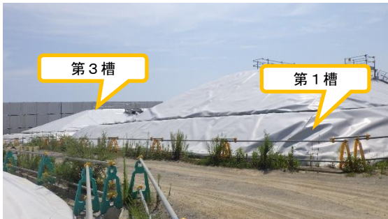
(写真4) 第1槽及び第3槽の状況
