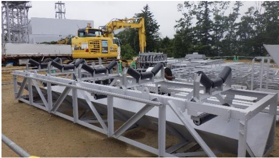
(写真4) 資機材の仮置き状況
