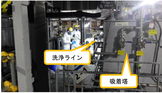
(写真1) 洗浄ライン敷設作業の状況
