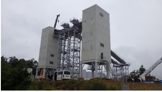
(写真3-2) バッチャープラントの設置状況
