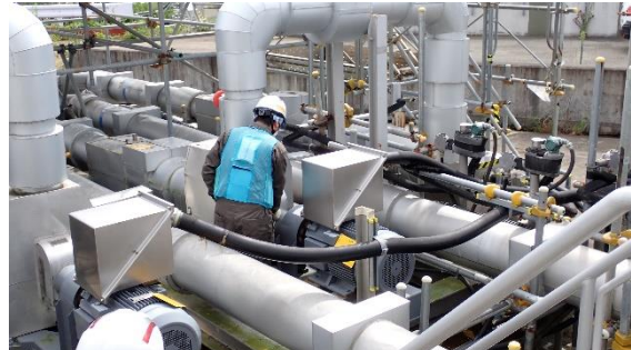
(写真 3) ポンプ起動後の確認
