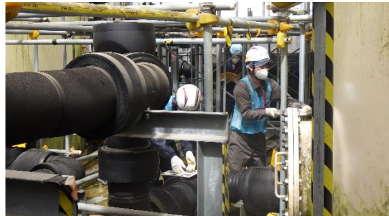
(写真 5) 排水弁の全開作業
