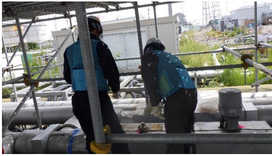
(写真 1 ①) ライン構成の状況
