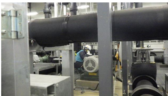
(写真 6) ポンプ起動後の確認
