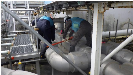
(写真2) 排水弁の全開作業
