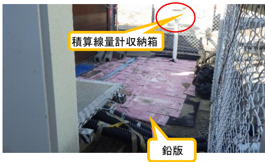
(写真6) 積算線量計の設置状況
