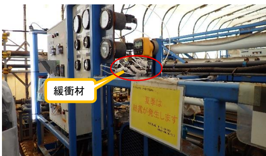
(写真3) 緩衝材の設置状況
