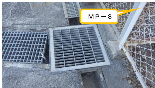
(写真7) MP-8周辺の側溝の状況
