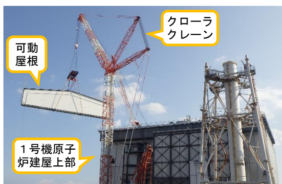
(写真3) クローラークレーンによる可動屋根(1ブロック目)の吊り上げ状況
