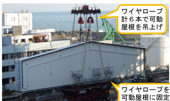
(写真2) 1号機北西側ヤードにおける可動屋根へのワイヤロープの固定作業の実施状況
