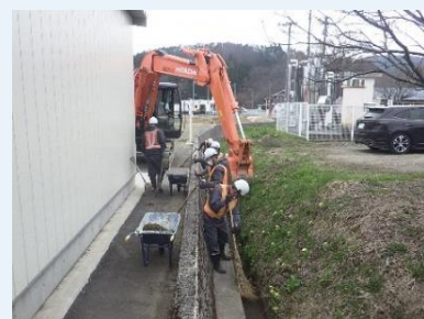
【側溝の土砂撤去奉仕作業】
