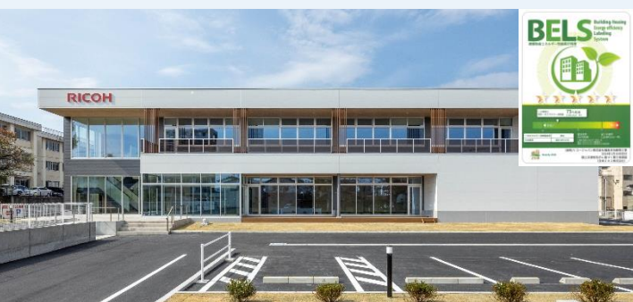
【NearlyZEB事業所（郡山）】
