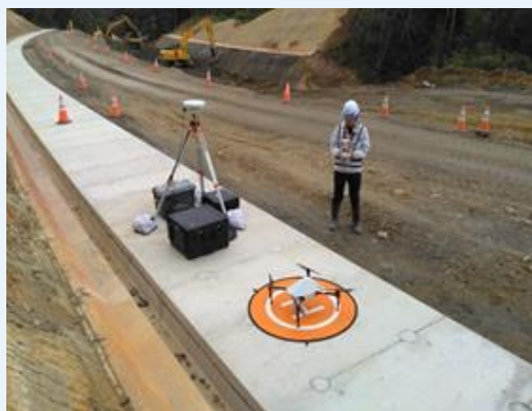
【ドローンを使用した進捗数量の確認】
