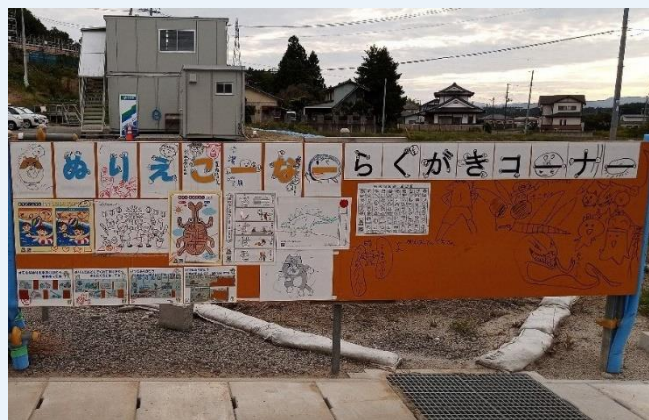
【工事現場入口付近に設けた「ぬりえコーナー、らくがきコーナー」】
