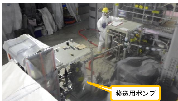
(写真 2 ②) 吸着材の移送作業
