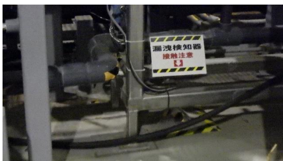
(写真 2－2) 漏えい検知器の設置状況①
