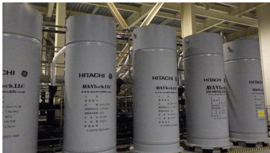
(写真 1－4) 吸着塔の設置状況（5基）
