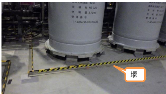
(写真 2－1) 堰の設置状況
