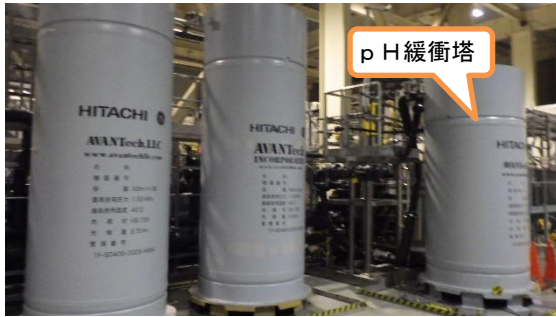
(写真 1－3) pH緩衝塔の設置状況
