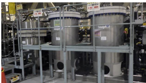
(写真 1－2) 前処理フィルタの設置状況 (3基)
