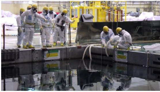
(写真 2 - 2) プール内における使用済燃料の キャスクへの装填作業状況②
