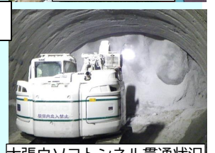
大張ウソコトンネル貫通状況
