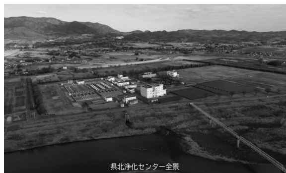
【県北浄化センター】
