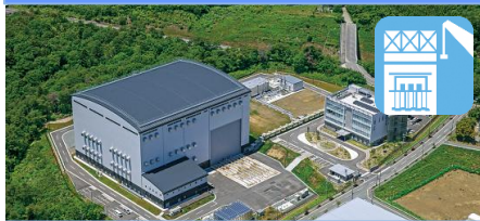
JAEC 楡葉遠隔技術開発センター 廃炉作業の実証実験(※1)
