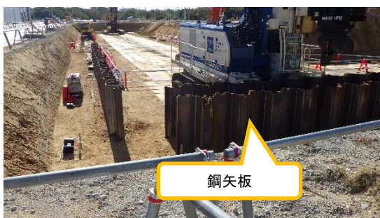
(写真 1 ①) 山留め工事の状況① (前回：令和 7 年 1 1 月 1 0 日撮影)
