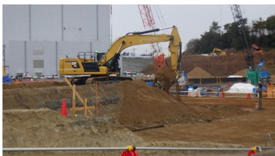
(写真 2 ①) 土砂搬出の様子①
