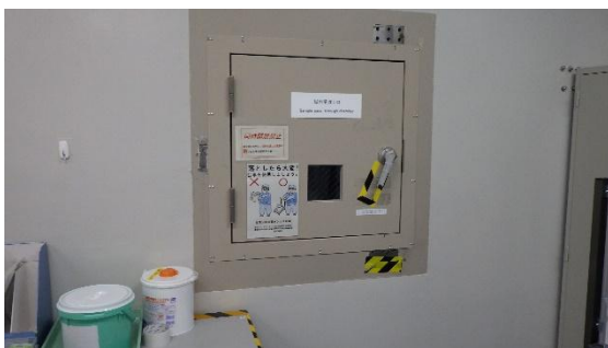
(写真2-2) パスボックス 前処理エリアと計測エリアの間に設けられている
