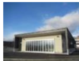
猪苗代水環境センター
