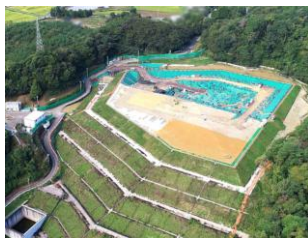
特定廃棄物埋立処分施設
