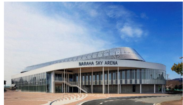
公共施設での地中熱利用の例：ならばスカイアリーナ(再エネ推進ビジョン2021)
