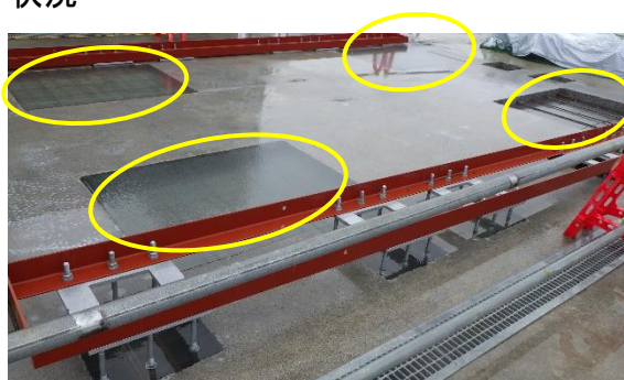
(写真 4) 基礎の研り作業の状況 ※黄枠の箇所に写真 1 の支柱が設置される。
