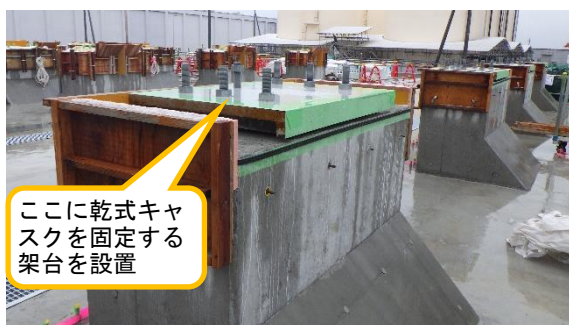
(写真 1) 乾式キャスクにおける支持架台の設置状況
