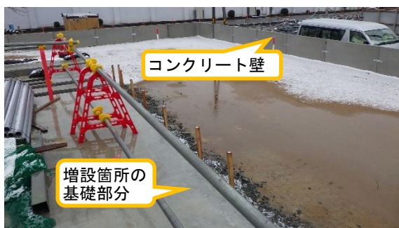
(写真 3) 増設箇所の外壁の状況
