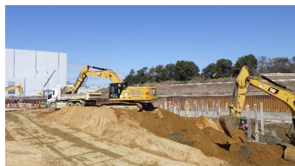
(写真2②) 土砂の掘削及び搬出状況 ② ※南東側から撮影
