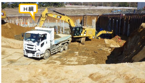
(写真2①) 土砂の掘削及び搬出状況 ① ※南東側から撮影
