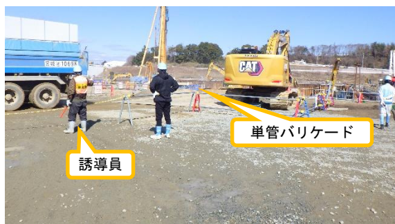
(写真3) エリア区分及び誘導員の設置状況
