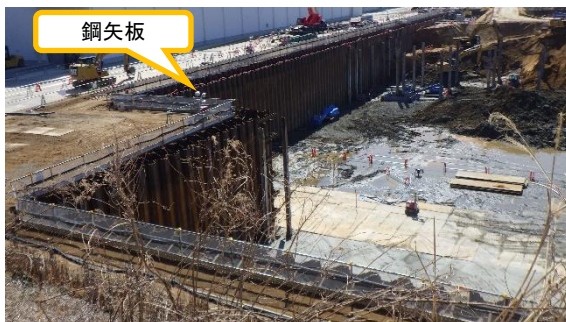
(写真1①) 北東側のエリア状況
