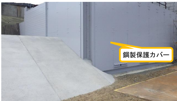
（写真1－1） 鋼製保護カバー設置工事の状況①
